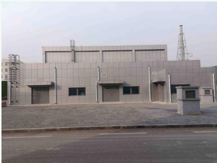
瓦房店基地新建污水处理站
